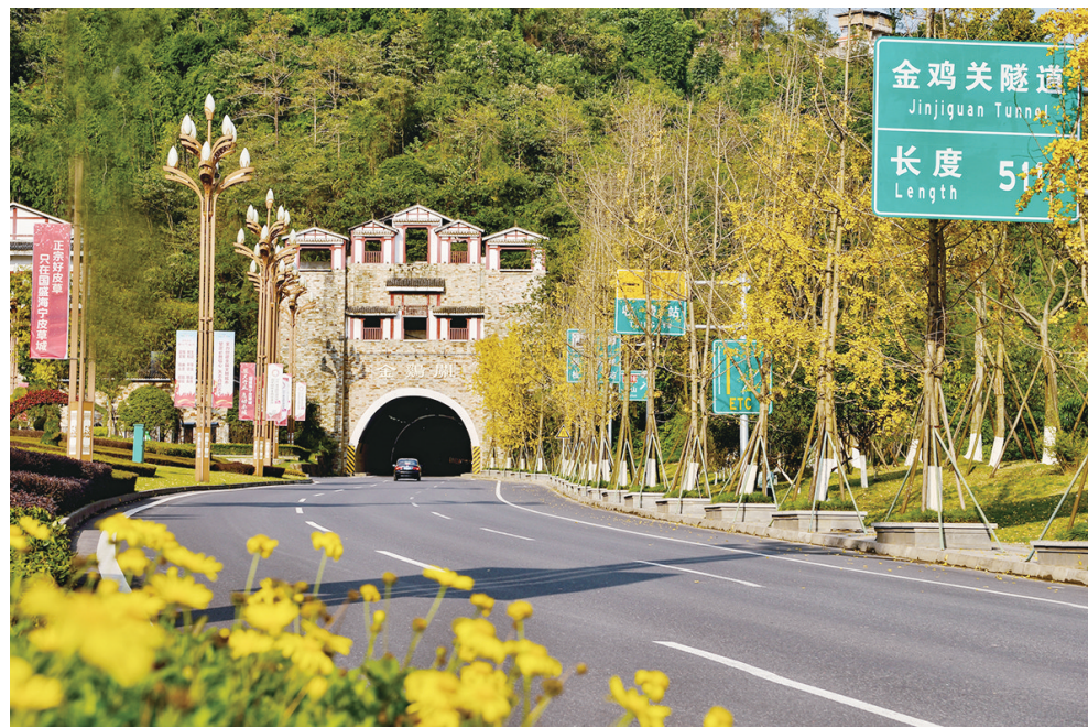
金鸡关公路隧道
