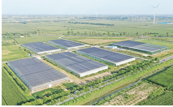
基础配套,水、电、天然气和通讯等设施齐全,田园综合体架构和雏形已基本成型。
