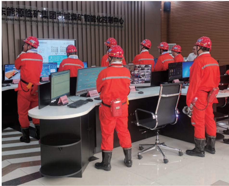
工作人员在监测、检修井下供电安全情况。
