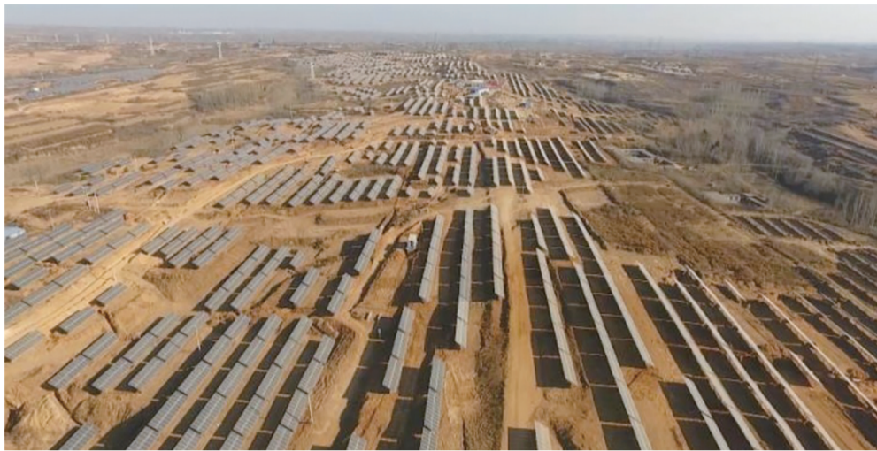
清洁、可靠、绿色、可持续的光伏电站蔚为壮观。
