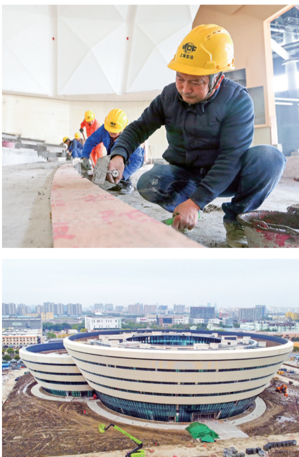
春节后,松江区职工综合活动中心复工建设,图为施工人员正在工地忙碌。 记者 岳诚 摄
