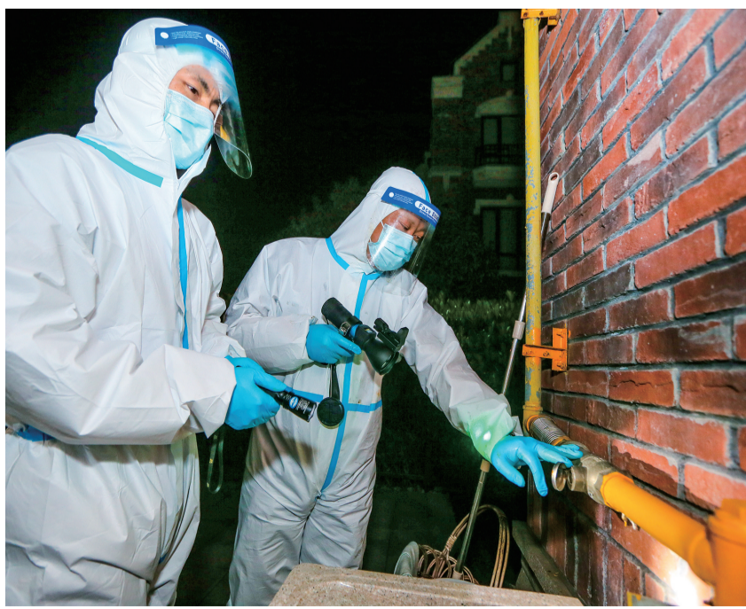
应急抢修人员身穿防护服,到居民家中开展检修。
