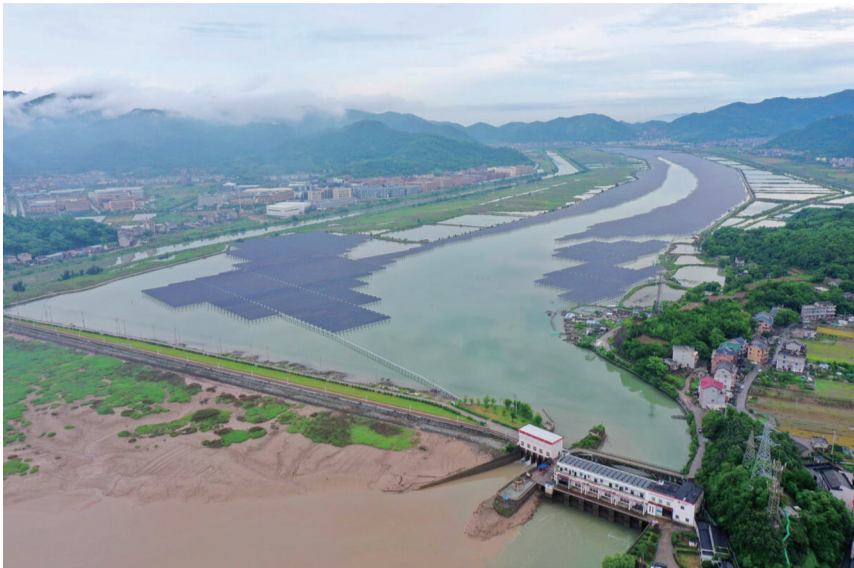
全国首座潮光互补型光伏电站实现全容量并网发电。前为潮汐电站,后为水面上的光伏发电板。
