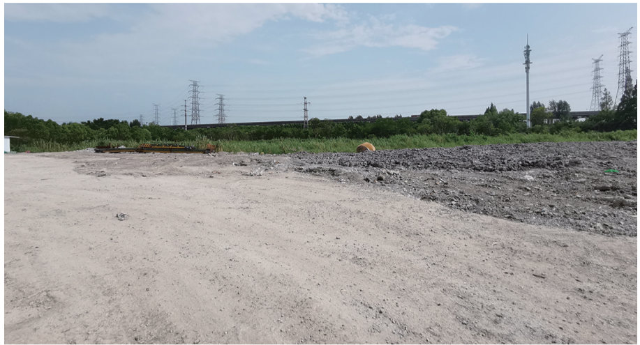
经整治,大江路露天碎石场扬尘现象得到有效遏制。 记者 陈菲茜 摄
