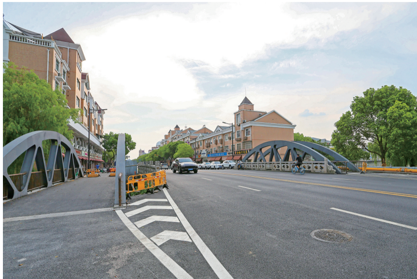
即将完成施工的鼓浪路张泾河桥。
