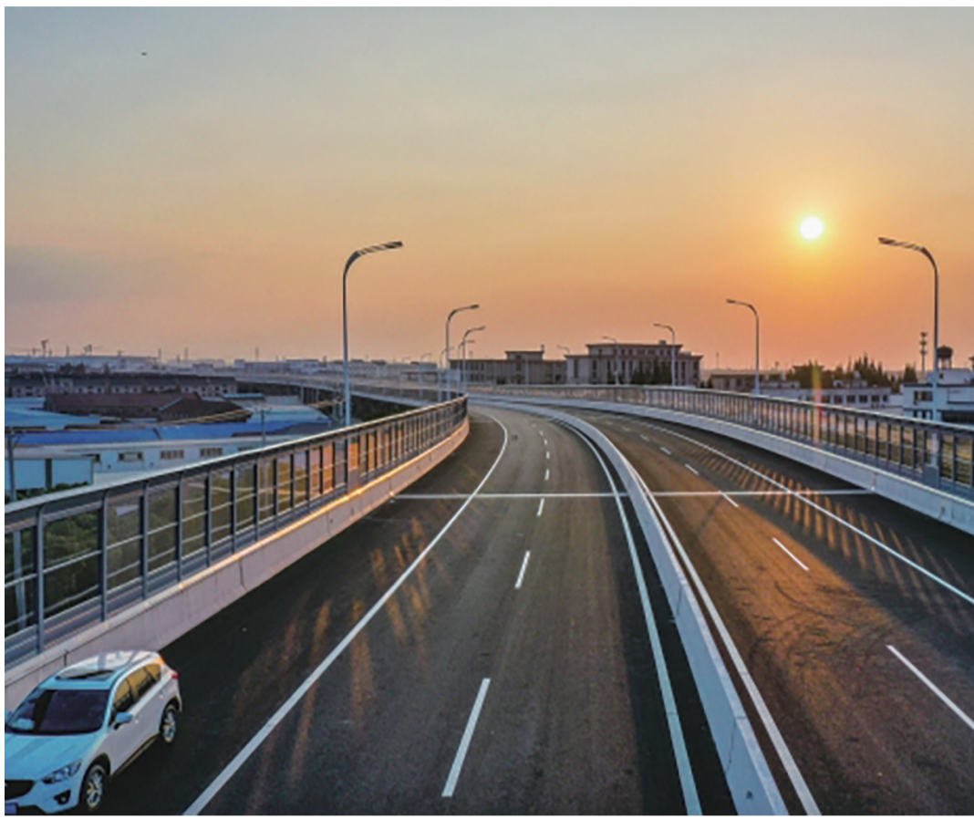
昨天,G524常熟莫城至辛庄段改扩建工程通过验收,全线通车。
