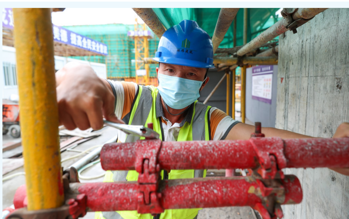
昨天,在小昆山镇四期安置房项目工地,工人正在检查加固脚手架,应对即将到来的台风。 记者 姜辉辉 摄
