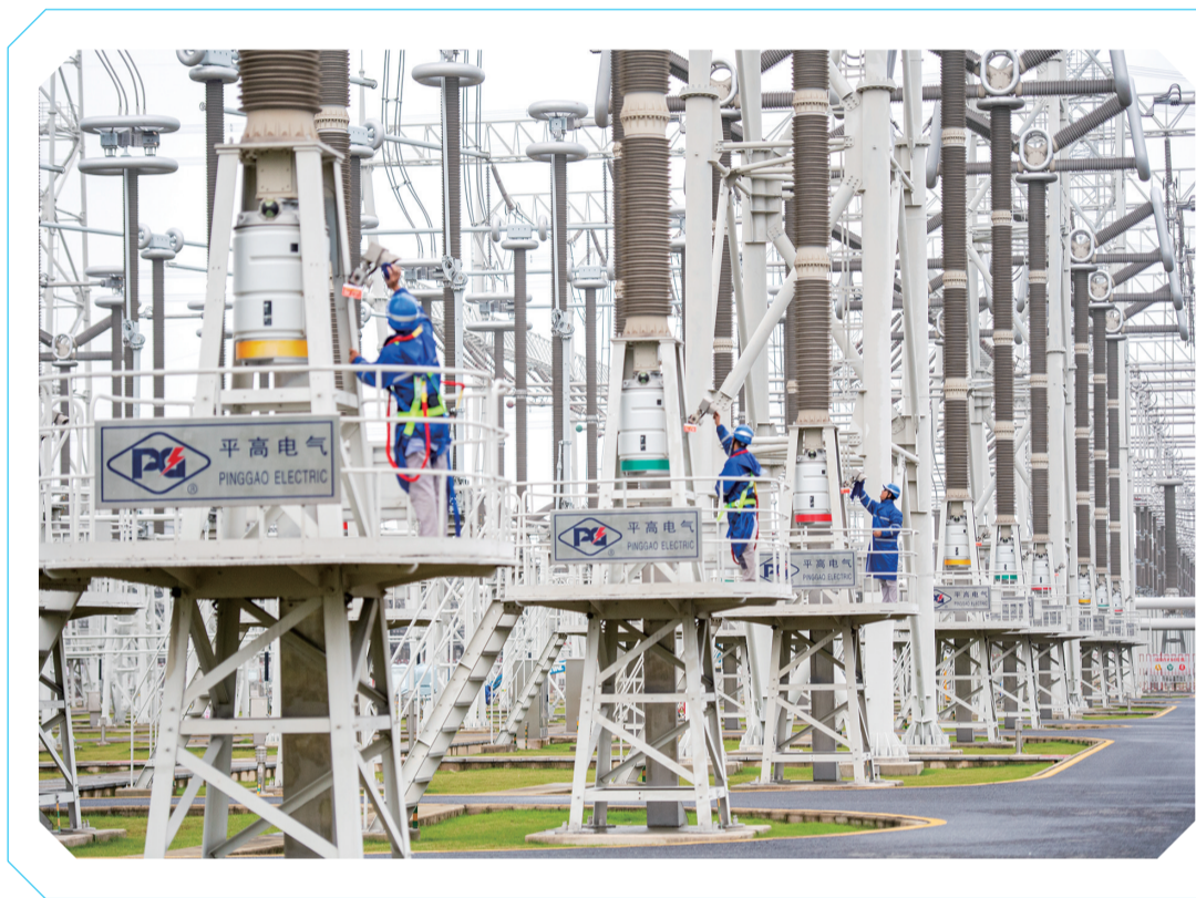
世界最高电压等级换流站完成“体检”。日前,国网安徽电力检修人员对古泉换流站设备进行检修、维护。当日,昌吉-古泉±1100千伏特高压直流输电线路的受端站——安徽宣城古泉换流站完成“体检”。连日来,国网安徽电力的700多名电力检修人员对古泉换流站进行集中检修,有序完成39个作业面共计5200余项工作,为电网的安全稳定运行打下坚实基础。 摘自新华社
