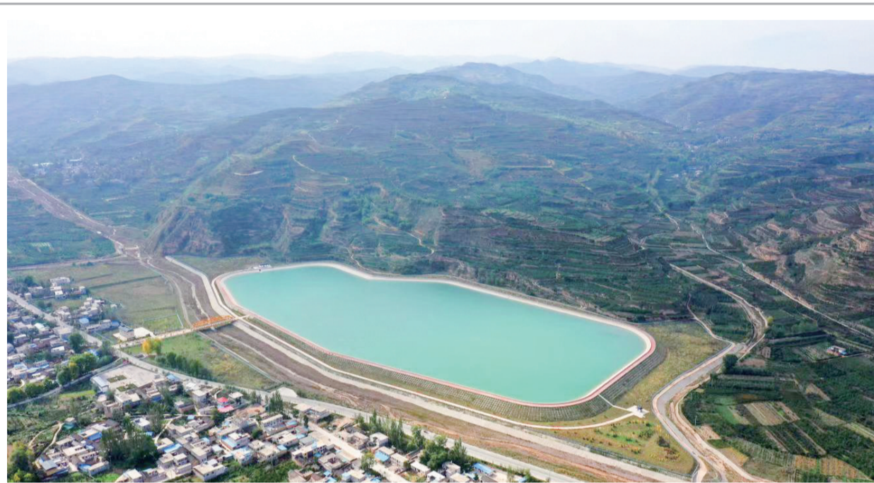
图为天水市藉口镇杨家湾调蓄水池。
