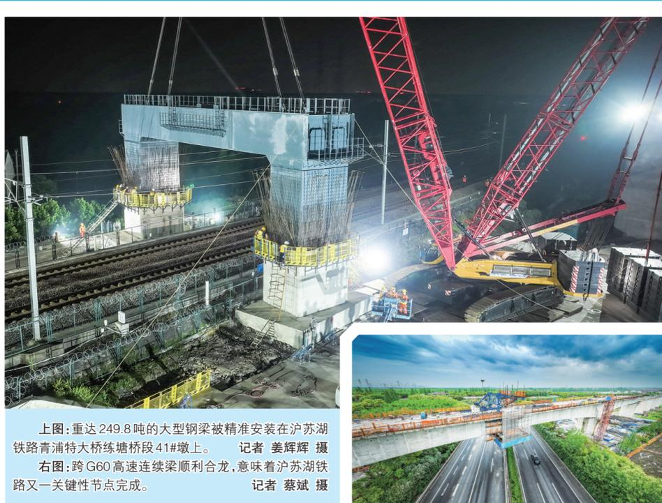
上图:重达249.8吨的大型钢梁被精准安装在沪苏湖铁路青浦特大桥练塘桥段41#墩上。 记者 姜辉辉 摄
