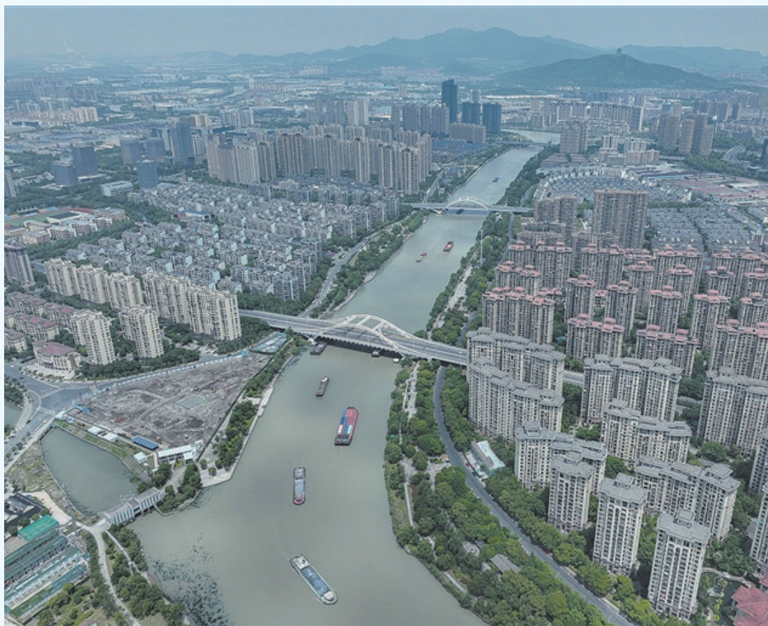
连日来,装载各类货物的船舶在长湖申线水城来回穿梭,呈现一派繁忙景象。近年来,湖州市港航管理中心大力发展“多式联运”“河海联运”,打造现代化内河航运体系示范先行区,推动一流内河枢纽港建设,构建现代化、智能化水上交通动态管控新格局。摘自《湖州日报》
