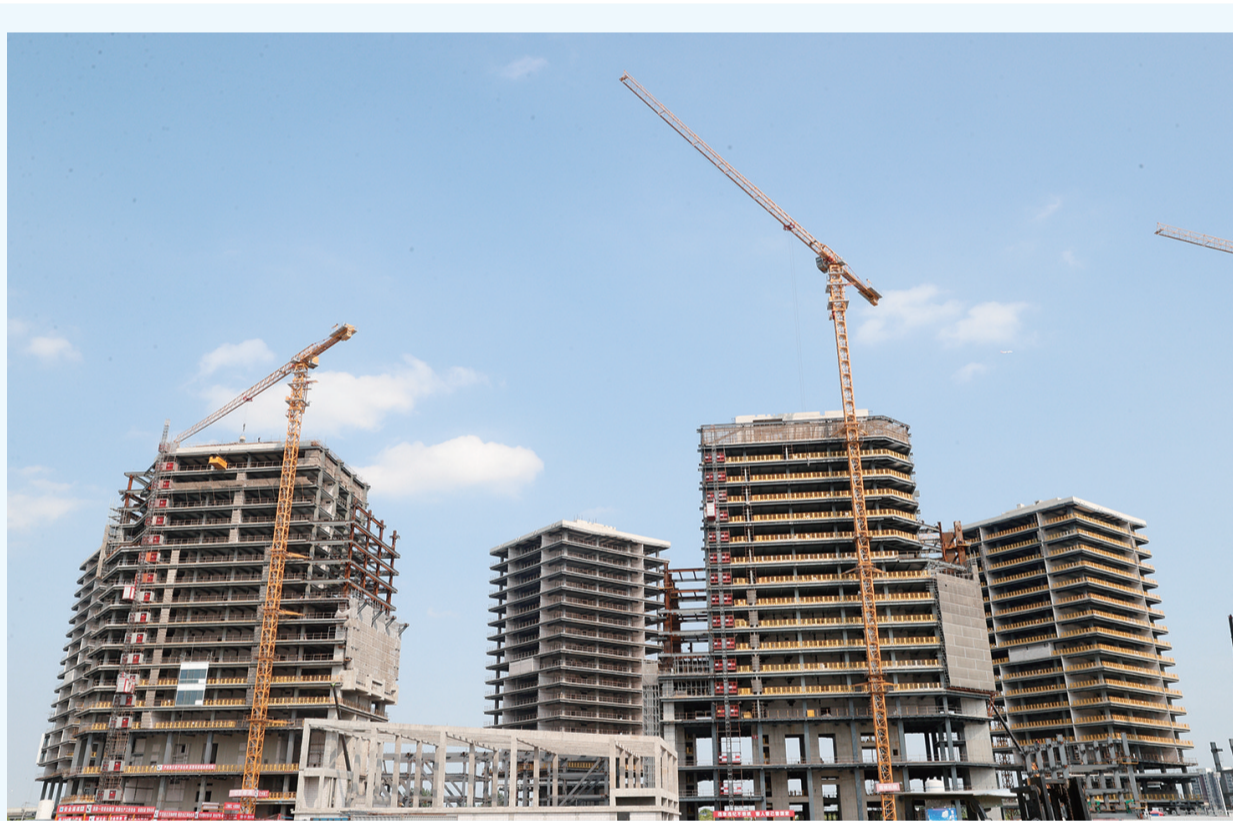
G60科创云廊二期项目已有10栋主体结构完成结构封顶。
