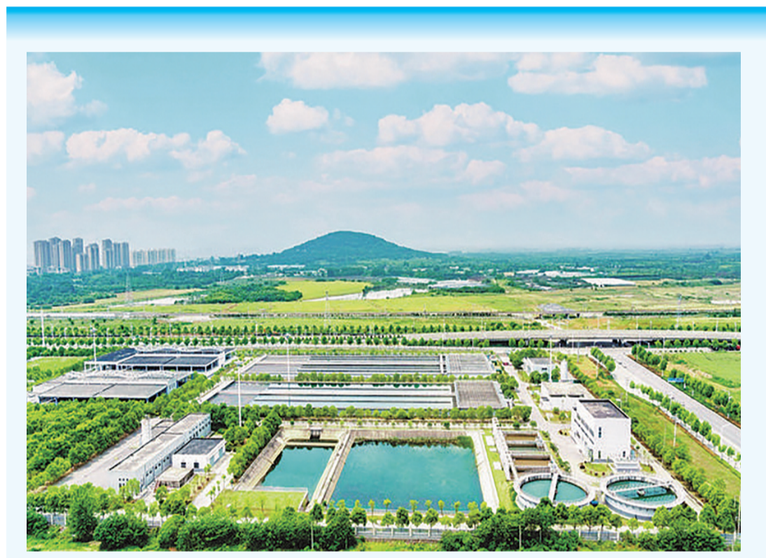
图为合肥七水厂三期工程建设俯瞰图。
