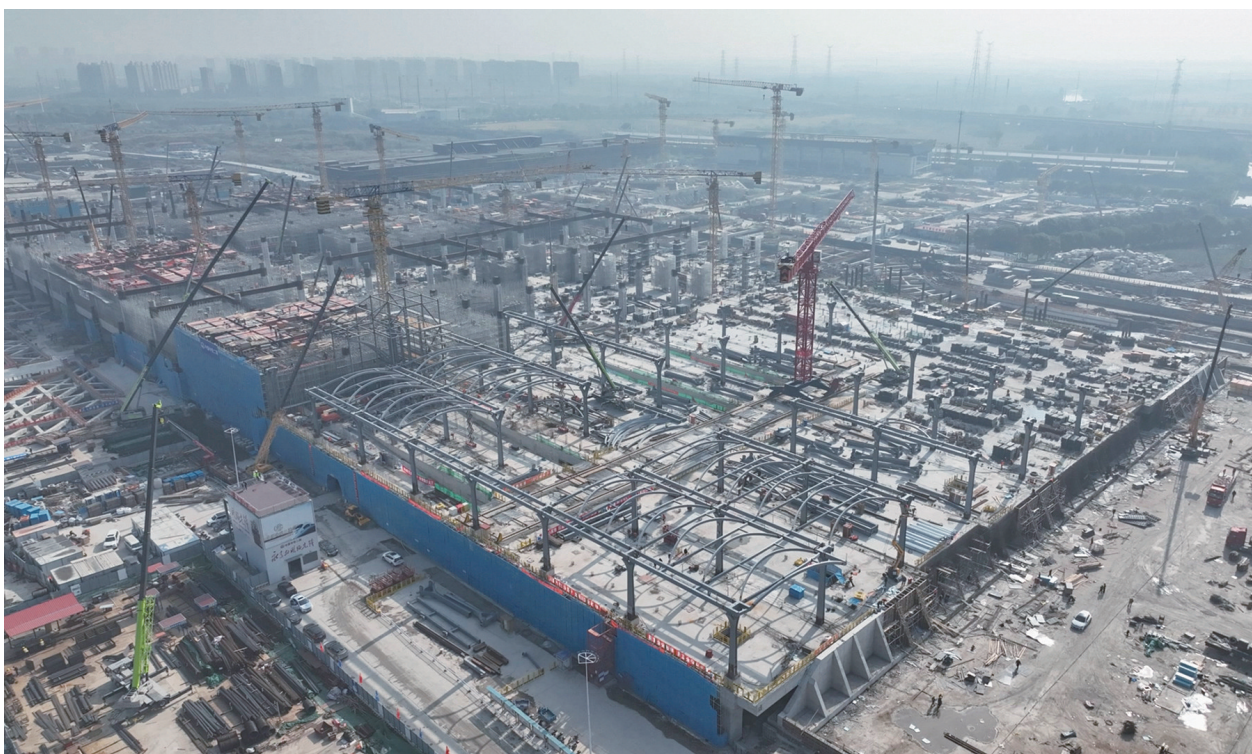
图为松江枢纽站体施工现场。
