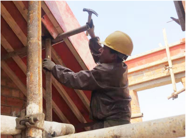
洋马镇贺东新农村社区二期项目 一次性建设100户,建筑面积约1.2万平方米,预计5月底交付使用。图为项目建设现场。
