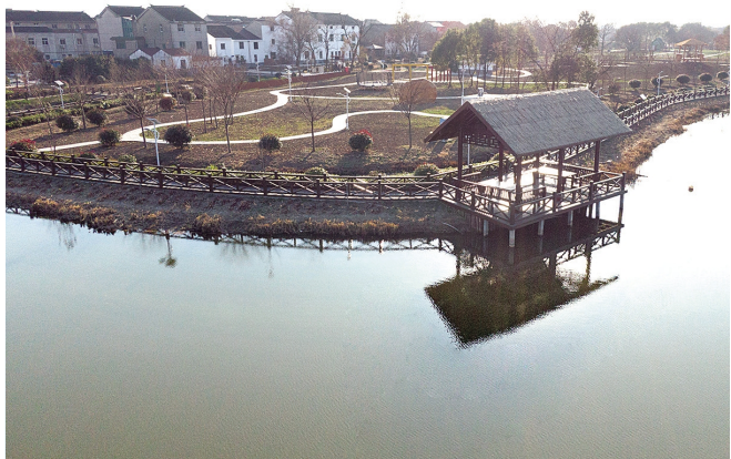
武进港一级支浜东洋岸河全长2.5公里,是洛阳镇一条具有行洪、灌溉功能的镇级河道。去年,洛阳镇完成了东洋岸河全线清淤工作,重构沿河两岸生态湿地系统,生态绿化种植2000平方米。目前,该河道水质稳定在III类水标准,展现出水美乡村的新风貌。徐芊卉 摄
