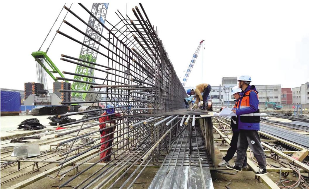
江苏南沿江城际铁路武进站枢纽项目是我区“两湖”创新区的重要交通枢纽工程。施工方中国建筑第八工程局有限公司项目部科学组织施工,已完成工程桩1353根,围护桩686根,立柱桩58根,三轴搅拌桩6514幅,SMW桩112幅,高压旋喷桩229根,冠梁390米,地连墙和墙趾注浆各152幅。目前已完成整体工程的30%。图为地连墙钢筋笼施工。
