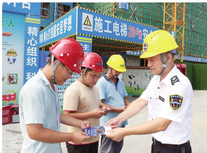
连日来,我区出现大范围持续高温天气,为切实维护劳动者合法权益,区劳动保障监察大队执法人员深入在建工地、企业,通过现场查看、询问走访等方式,广泛宣传高温天气劳动保护相关政策法规,检查在高温天气情况下落实劳动保护相关政策的情况。(吴凌寒)
