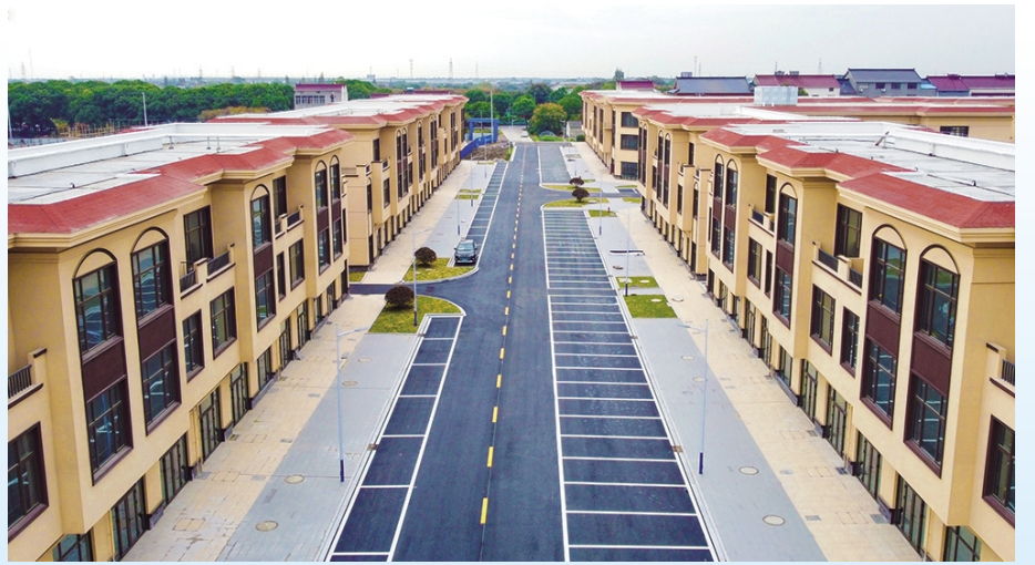
今年,嘉泽镇成章村为延长农业产业链,带动新型服务业发展,推动三产融合,推进商业街区建设。该街区位于集镇商贸核心区域,底商面积7500平方米,可进驻商户91户。两侧为临街商铺,将以花木园艺经营为主营业态,并兼容餐饮、住宿等生活配套,进一步促进本村农民原地就业创业。目前,街区主体建筑已竣工,正在进行绿化、水电等配套工程建设,预计年底通过验收并投入使用。徐芊卉 摄
