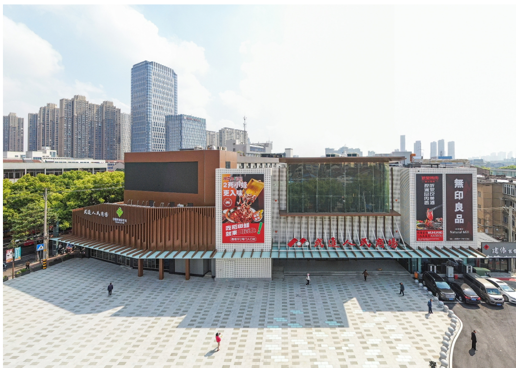
目前,武进人民商场升级改造已完成,将于4月30日正式营业。升级后的武进人民商场总面积超8000平方米,涵盖潮流餐饮、时尚休闲、精致购物、亲子教育多种消费业态,同时满足居民购物、餐饮、休闲、娱乐、社交、学习的综合性消费需求。图为焕然一新的武进人民商场。 陆新 徐晶玮摄
