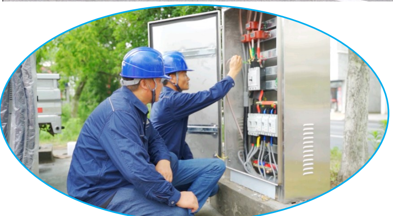
工作人员正在对充电桩进行安装调试
