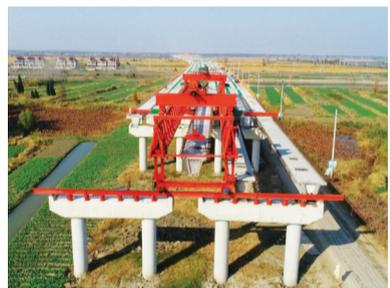
阜溧高速公路施工单位抓住时机组织机械、人员作业,图为施工人员正在架设公路桥梁。梅立成 摄
