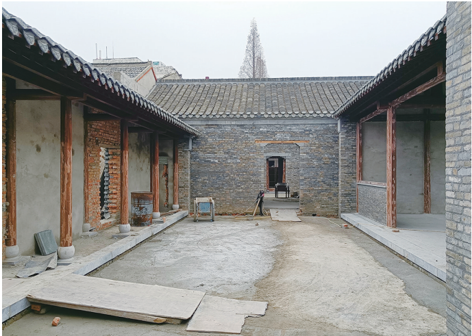
修复中的月塘地下交通站旧址。
