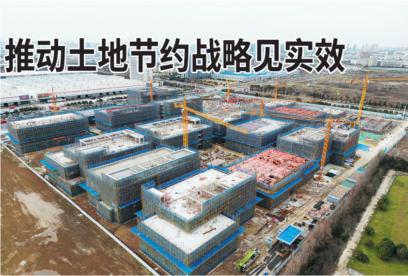
建设中的宇桥生态科技园项目
