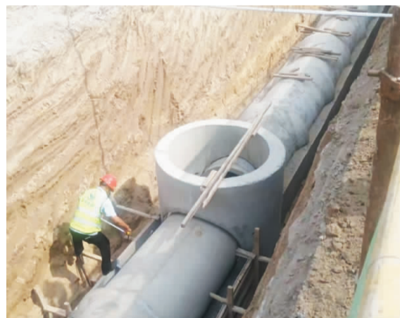
排水管网改造项目建设正在快速顺利推进
