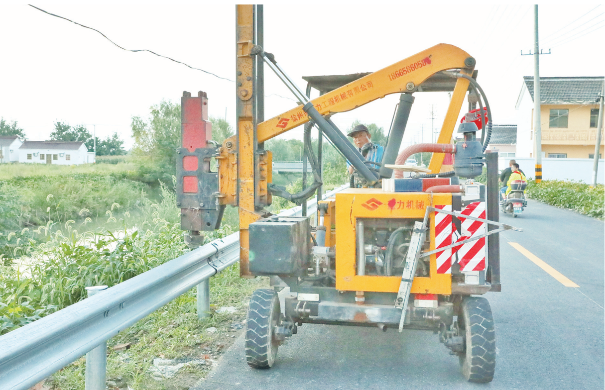
近日,施工人员在白驹镇三七公路边安装波形安全护栏。据悉,该镇大力实施农村公路安保工程,在全镇200公里镇村公路临险、临水等路段统一安装防护栏、防护桩,确保城乡居民出行安全。 单培泉 董汝涛 摄
