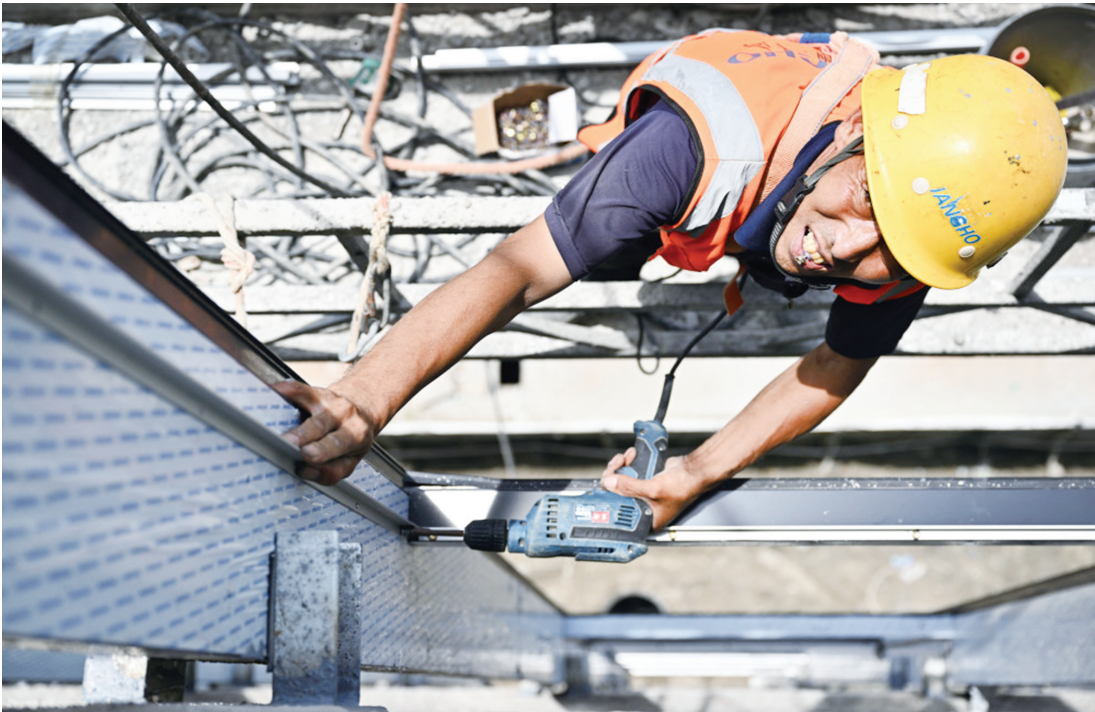
两年来,海口江东新区围绕基础设施建设、重大项目落地、招商引资引智等方面全面加速,高质量高标准推动园区开发建设。目前已引入重点企业183家,其中世界500强35家。总部经济区在建的14个项目中,已有7个项目实现主体结构封顶。图为6月21日,工人在国投生态环境大厦项目工地施工。 新华
