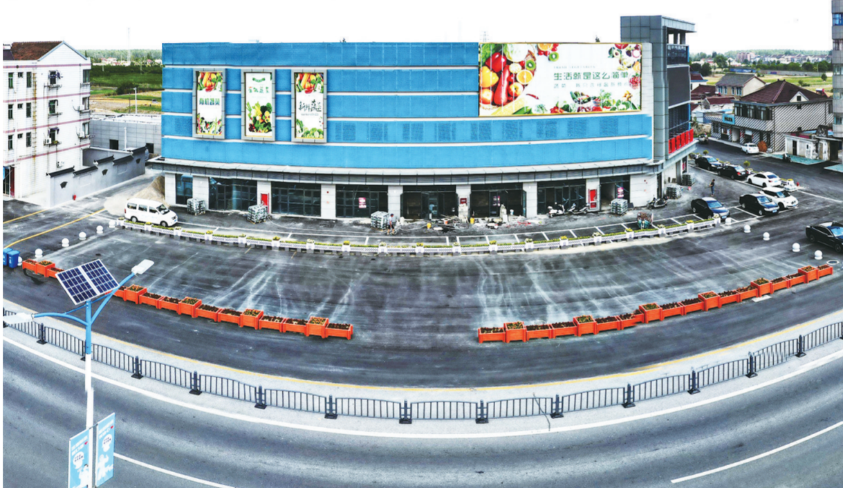
作为“省为民办实事工程”,草堰镇新农贸市场项目总投资约2500万元,总用地面积3809平方米,建筑总面积4575平方米,共设商铺56间、管理用房6间、摊铺521平方米,机动车停车位72个,非机动车停车位169个,建成后将进一步完善集镇公共配套服务功能。目前,该项目主体全面竣工,正在进行室内装修和附属工程施工,预计8月份正式对外营业。
