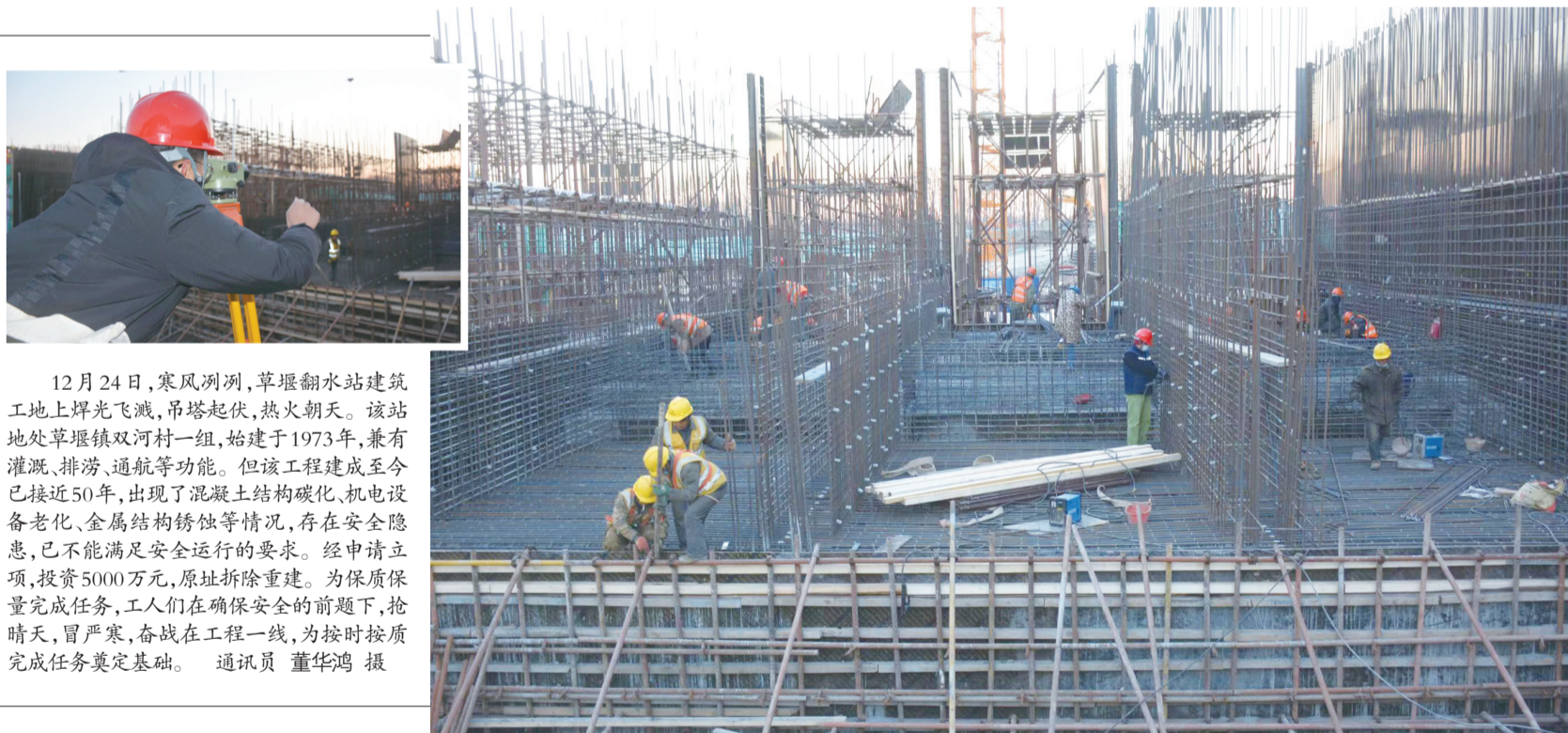
12月24日，寒风冽冽，草堰翻水站建筑工地上焊光飞溅，吊塔起伏，热火朝天。该站地处草堰镇双河村一组，始建于1973年，兼有灌溉、排涝、通航等功能。但该工程建成至今已接近50年，出现了混凝土结构碳化、机电设备老化、金属结构锈蚀等情况，存在安全隐患，已不能满足安全运行的要求。经申请立项，投资5000万元，原址拆除重建。为保质保量完成任务，工人们在确保安全的前提下，抢晴天，冒严寒，奋战在工程一线，为按时按质完成任务奠定基础。 通讯员 董华鸿 摄
