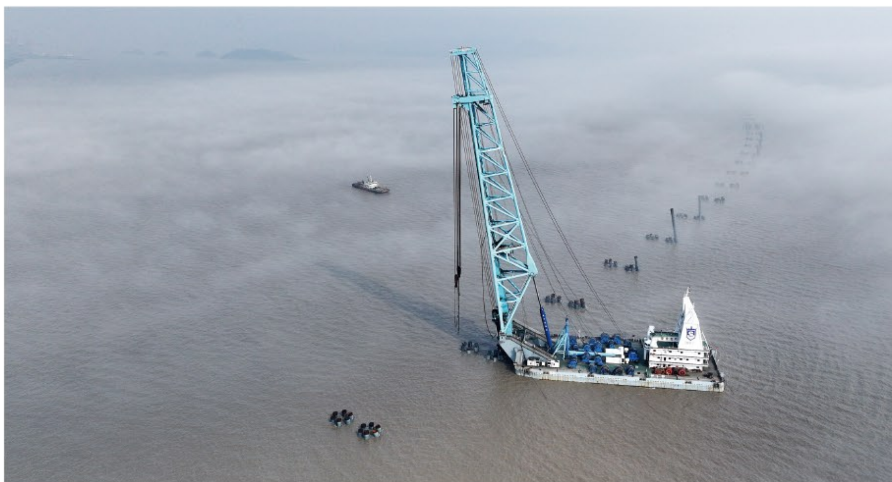
4月1日,浙江省舟山市青龙门水城薄雾飘渺,由550根钢管桩串连而成的青龙门特大桥西引桥水下桩基群似巨龙出水,若隐若现,蔚为壮观。图为当日拍摄的浙江省舟山市青龙门特大桥西引桥水下桩基群(无人机照片)。青龙门特大桥是跨海连岛工程——宁波舟山港六横公路大桥二期关键控制性工程,双主跨756米横跨青龙门水道,连接舟山佛渡岛和宁波梅山岛两座岛屿。新华社
