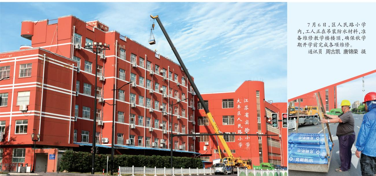
7月6日,区人民路小学内,工人正在吊装防水材料,准备维修教学楼楼顶,确保新学期开学前完成各项维修。
