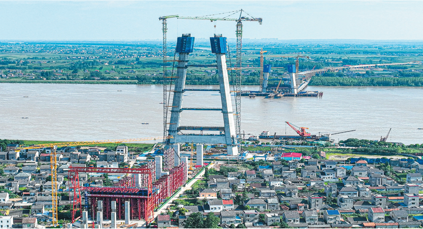
图为7月18日拍摄的湖北枝江百里洲长江大桥施工现场(无人机照片)。当日,历经9个小时连续浇筑,由四川路桥集团大桥公司承建的湖北枝江百里洲长江大桥,北岸边跨现浇梁首件成功浇筑完成。百里洲是长江枝江段一座大型江心洲,面积约228平方公里,人口近10万人。长期以来,洲上的居民出行只能依靠轮渡。正在建设中的枝江百里洲长江大桥全长1549米,预计2026年建成通车。
