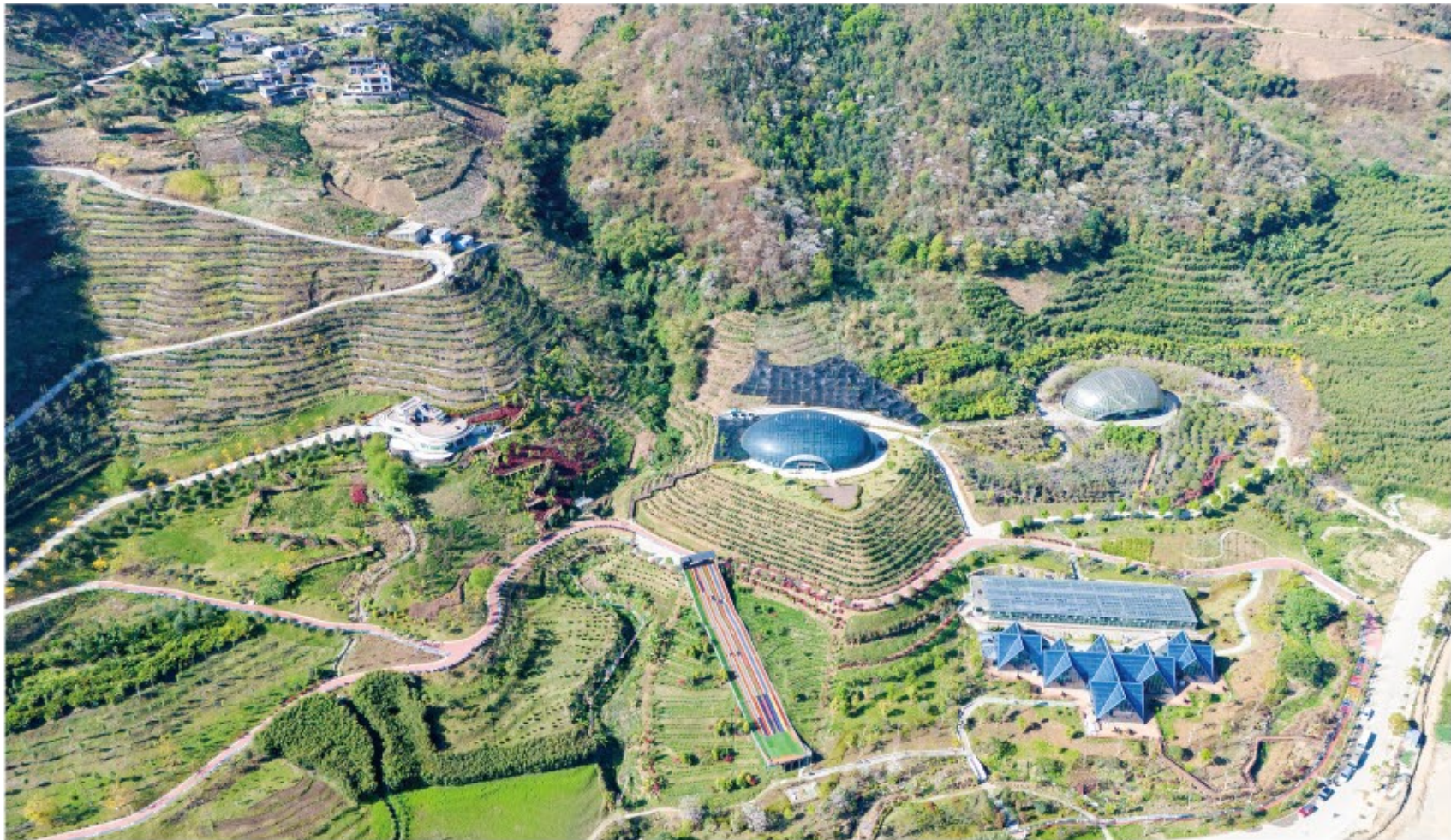
3月26日拍摄的中交怒江绿色香料园区(无人机照片)。近年来,云南省怒江州通过打造中交怒江绿色香料园区、在安置社区兴建棒球工厂等特色产业项目,让群众在家门口就业,有效破解易地扶贫搬迁群众就业增收难题,为巩固脱贫攻坚成果与乡村振兴有效衔接提供了有力支撑。
