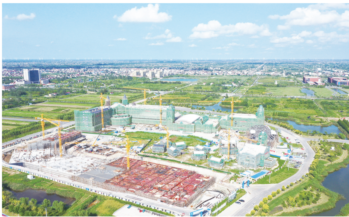
8月22日，荷兰花海天沐温泉国际度假酒店项目现场塔吊林立，一派繁忙。该项目总投资11.5亿元，酒店总客房数超300间，主要由21栋不同文化融合的特色度假酒店群组成，拥有超万平方米的室内外温泉文化汤池、温泉文化博物馆及超5万平方米的温泉文化公园，是荷兰花海着力打造休闲旅游度假区目的地的而建设的中心功能平台，也是荷兰花海养生中心核心项目载体、景区四大名片之一。 万成 摄
