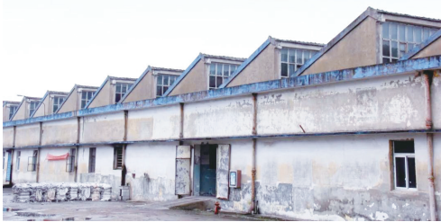
大桥轧花厂旧厂房
