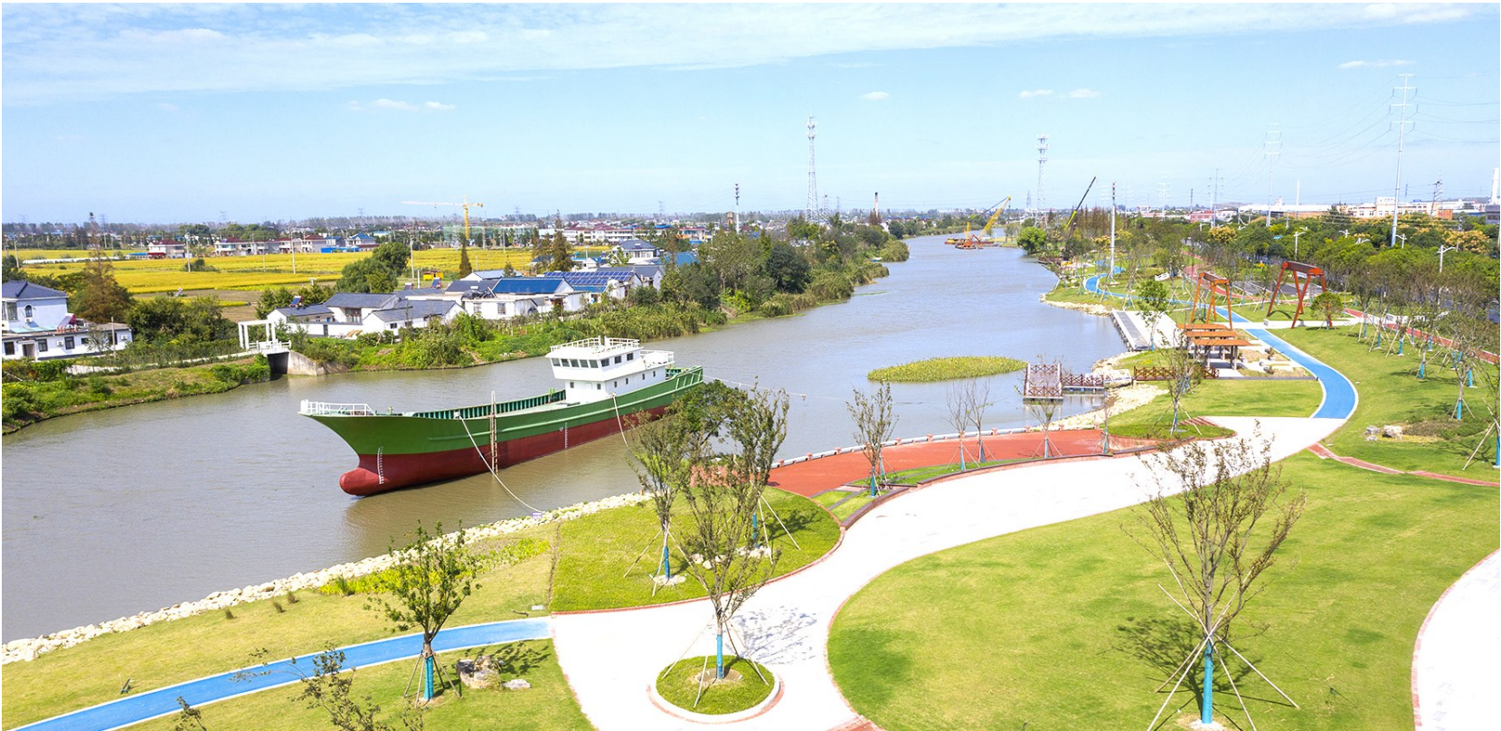
串场河生态廊道项目紧扣“盐文化”主线,致力打造集“景、产、人、文”于一体的生态景观旅游文化带。图为整治后的串场河城市段一标段现场。
