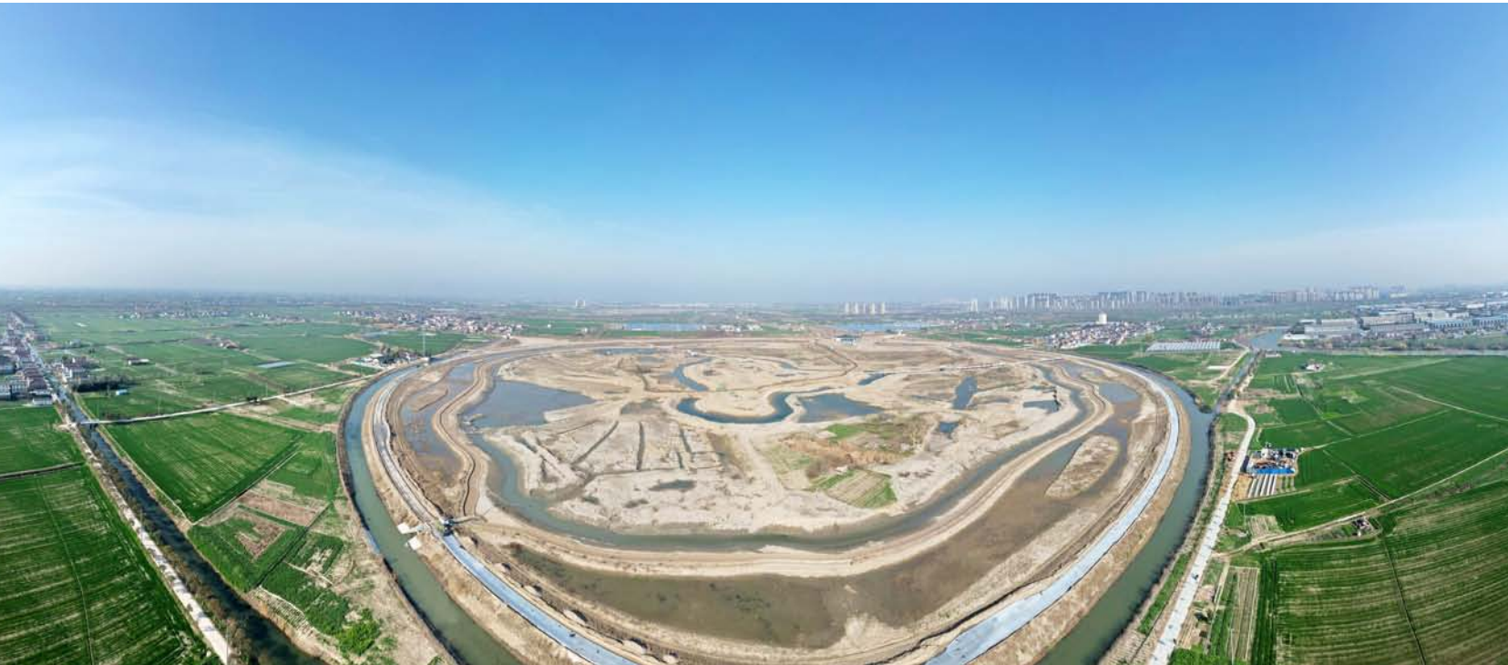
市应急饮用水源工程主体雏形初现。施工现场,工人正在加快推进生境岛、环湖游步道建设进度,大型机械有条不紊地挥臂作业,车辆来回穿梭。该项目建成后可增加有效蓄水量210万立方米,满足全市7天应急供水,保障城乡居民饮用水安全。练益华 摄
