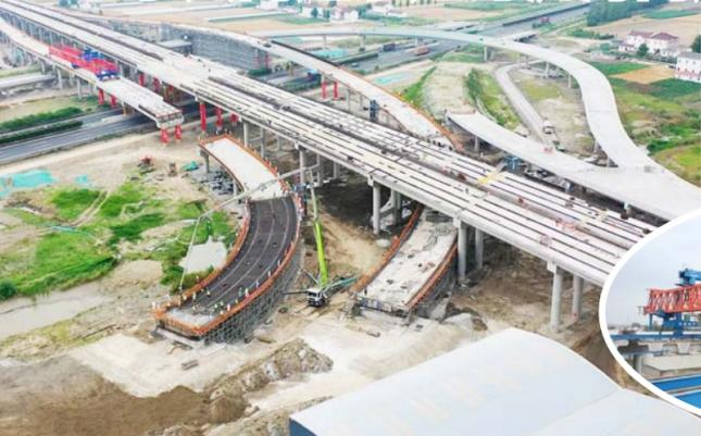
重逾百吨的预制梁稳稳地推送到预定位置,东延跨沈海高速特大桥主线桥全线合龙。至此,东兴高速和东兴高速东延工程主线连通,优美的环形造型全面呈现。
