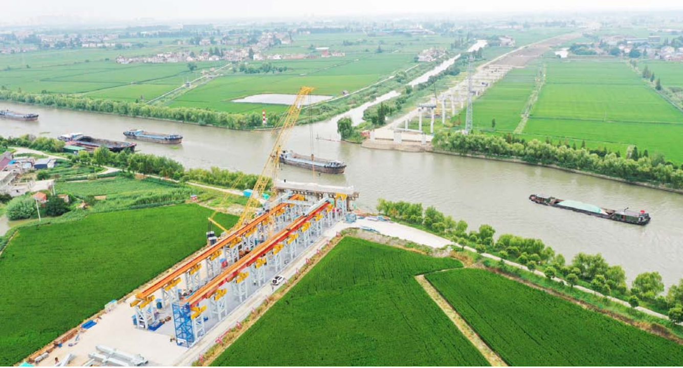
东兴高速泰东河大桥位于五烈镇钱家村境内,是全线重点攻坚工程之一,也是全线唯一一座简支钢桁架结构桥梁,主桥长105.8米,采用预装、顶推工艺施工。目前,工人正有条不紊进行钢桁架建设,预计10月中旬可进行桥梁顶推施工。
