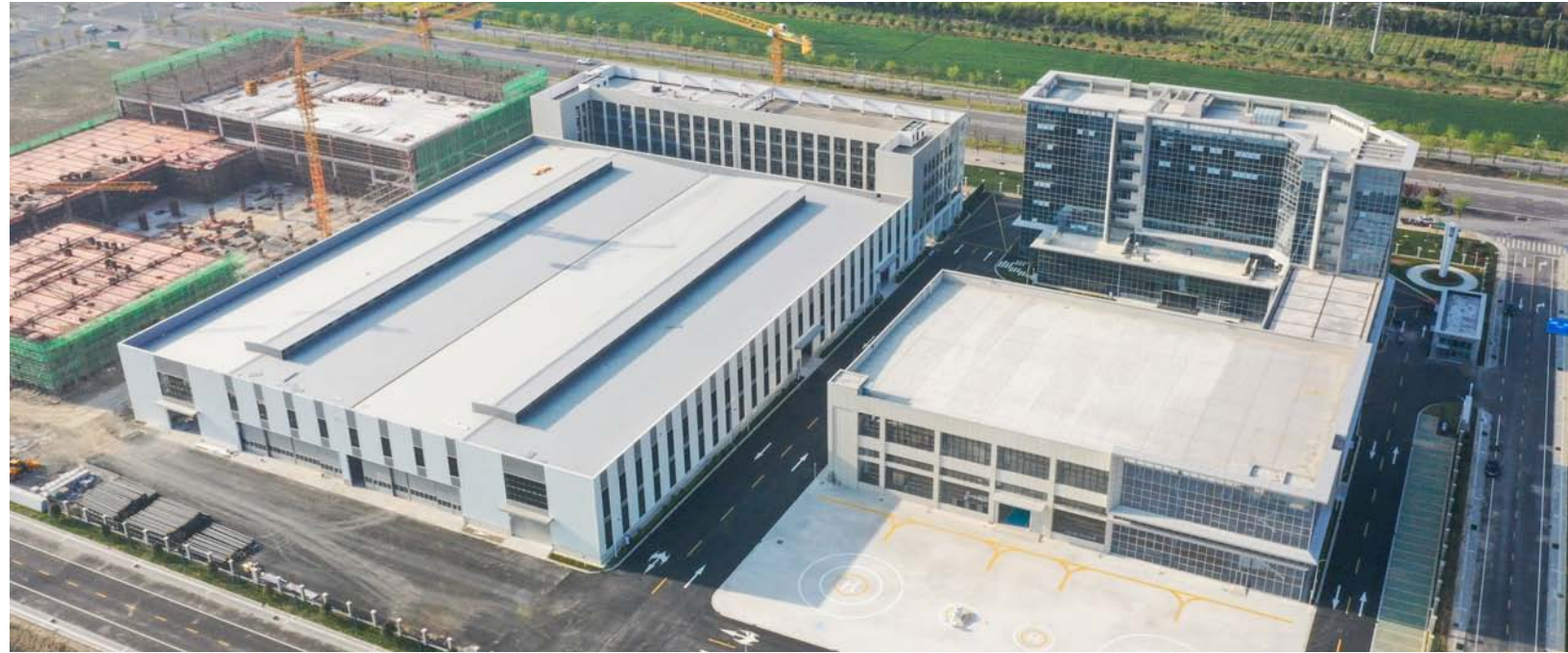
东台联合飞机无人机产业基地项目是联合飞机集团在华东地区布局的最大运维基地和重要制造基地。目前，该项目综合楼一层精装修完成，3号车间6条装配线进场，4号车间主体施工完成。本报记者 丁圣 摄
