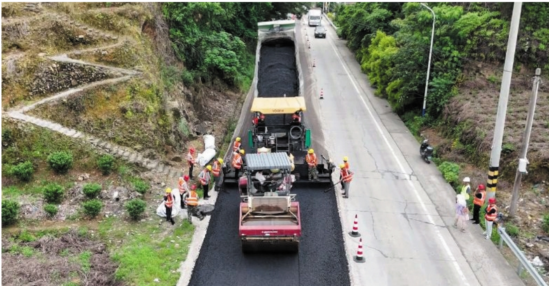
近日,G228线福鼎白琳镇翁江村至沿州村段路面改造工程项目正在紧锣密鼓地推进中。项目工期5个月,目前正在进行水稳层摊铺,预计在今年10月底完成交付。夏岩缘 摄
