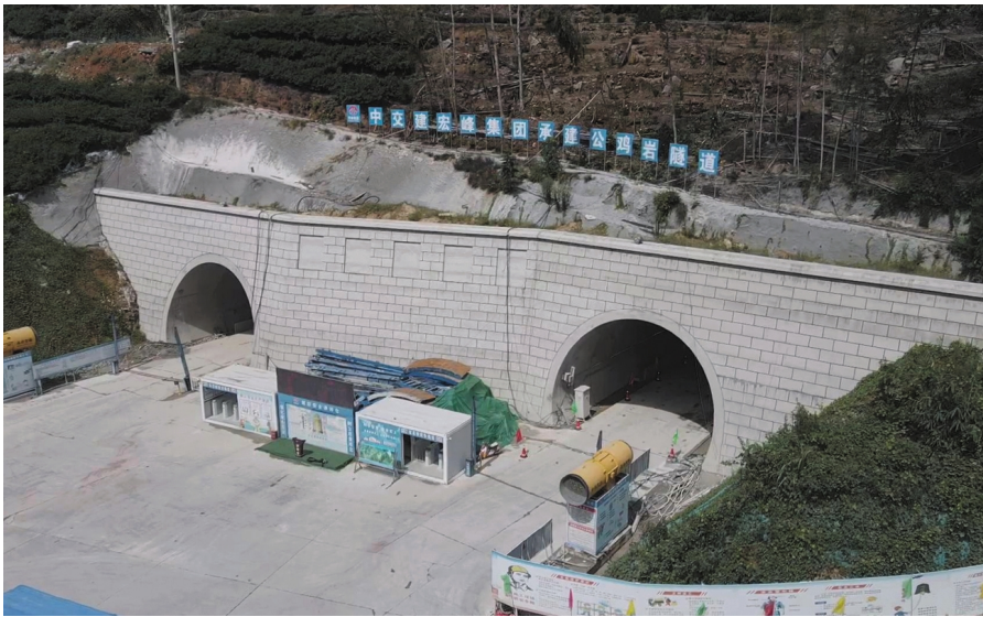
9月26日上午,国道G228线福鼎市白琳镇小白岩至店下段工程(甬莞高速店下互通及接线工程)A1标段关键控制性工程——公鸡岩隧道顺利贯通,标志着G228线福鼎段建设取得阶段性重大突破。
