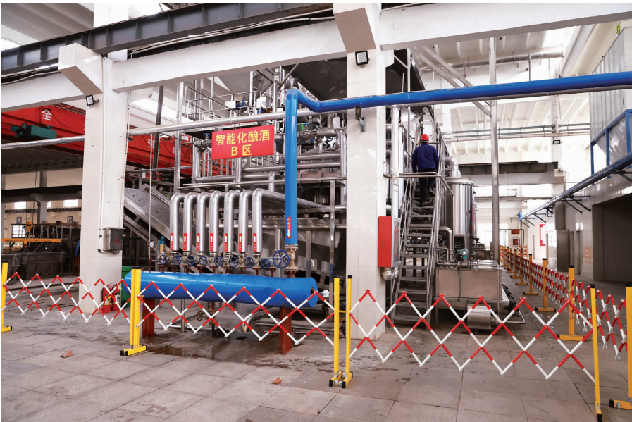
1310 车间完成全面升级改造
