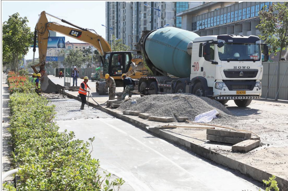
图为县城建设路雨污分流改造及道路提升工程正在加快推进。该工程西起生态路、东至伊尹路，全长2.55公里，道路红线32米。主要建设内容为机动车道沥青混凝土摊铺及绿化带、慢车道、人行道提升改造，新建雨污管道、检查井，交通信号灯及路名牌安装。工程总投资约2760万元，于6月份动工，计划11月底完工并投入使用。
