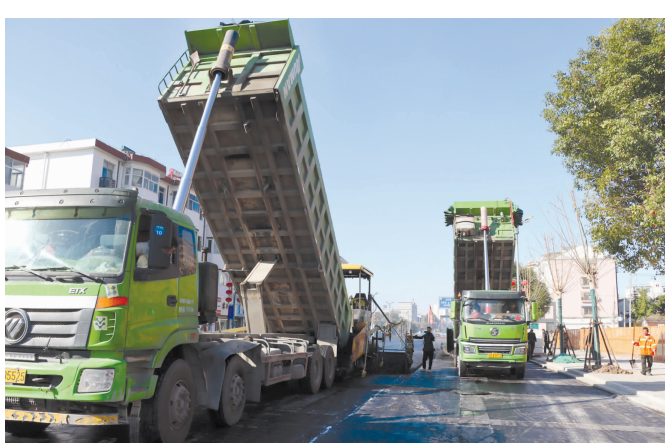
胜利路雨污分流改造及道路提升工程东起振兴路、西至幸福大道,全长2.2公里。目前已完成地下工程,开始上层沥青摊铺,月底可完成整个工程任务。(徐云邦 魏士化 摄)
