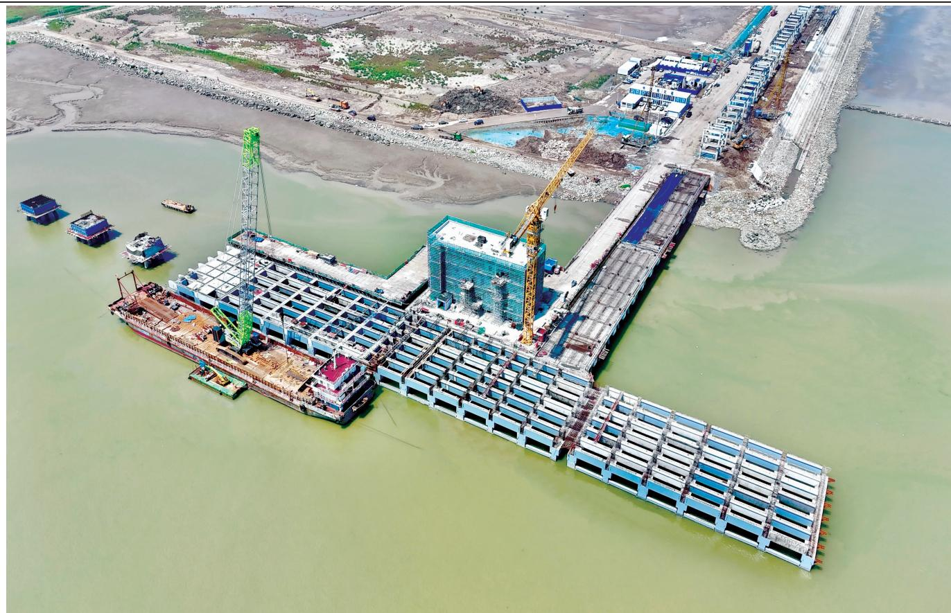
日前，随着转运驳船内最后一榀前边梁稳稳放置于预定位置，由中交广航局承建的连云港港灌河港区燕尾作业区液体散货泊位项目一期工程码头预制纵梁安装全部完成，为码头主体结构完工奠定了坚实基础。该项目一期工程码头工作平台长195米、宽25米，共有3个结构段，安装预制纵梁140件。
